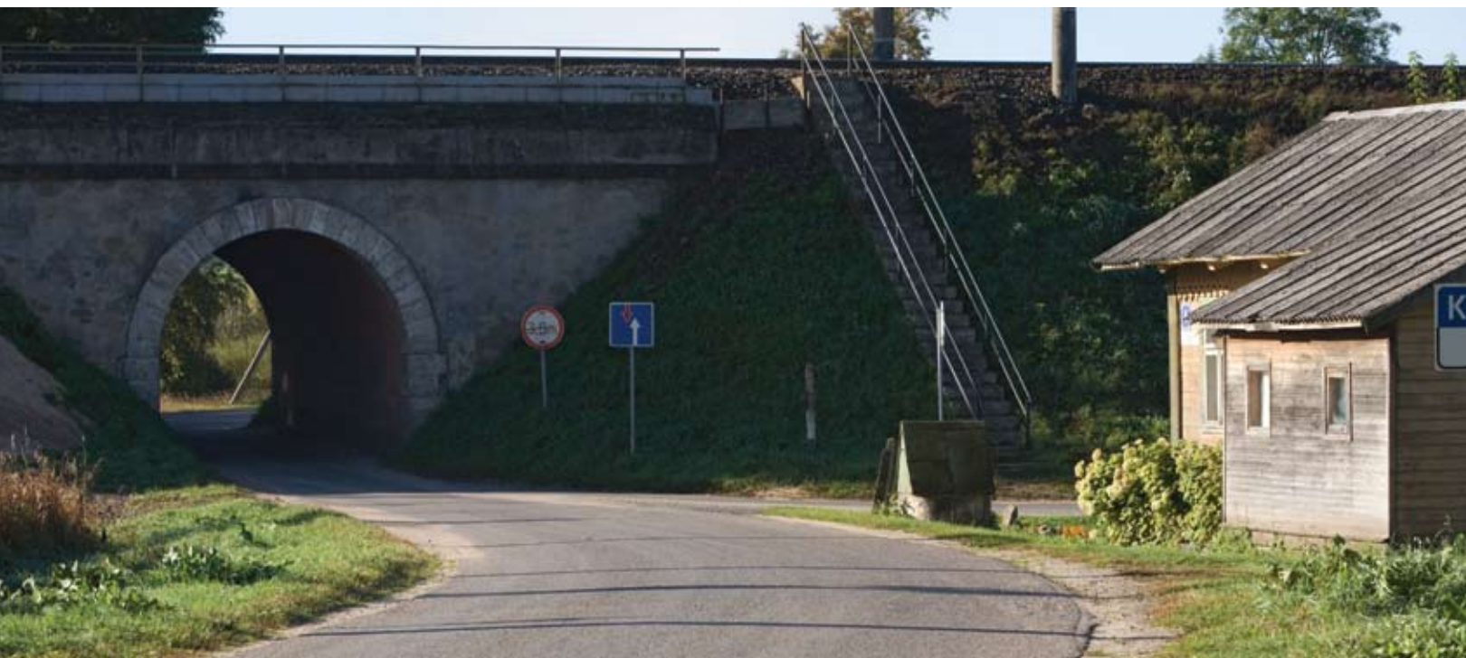
Geležinkelio viadukas Kaišiadoryse
